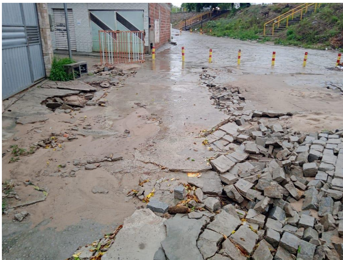
Figura 2: Ponto de desgaste em pavimentação de rua Castro Alves da cidade de Santaluz. Andrade, Tony, em 06/11/2021.
