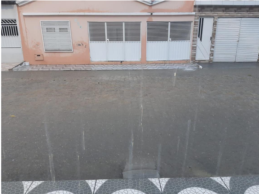
Figura 3: Foco de alagamento em rua da cidade de Santaluz registrado durante as chuvas. Andrade, Tony em 02/11/2021.
