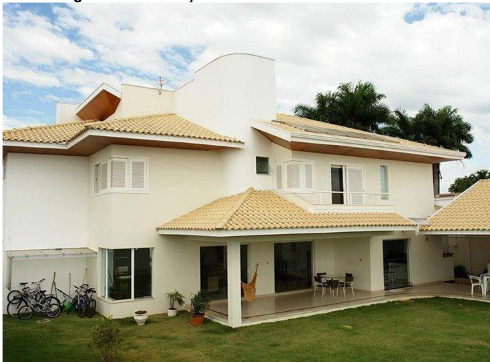
Figura 02: Construção com cobertura de telha cerâmica
