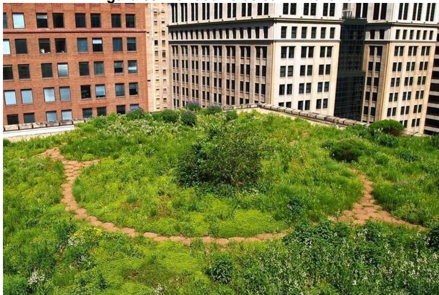
Figura 09: Telhado verde semi-intensivo.
