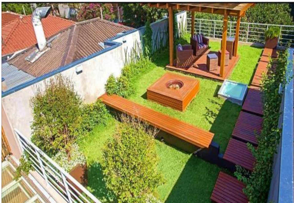
Figura 08: Telhado verde intensivo
