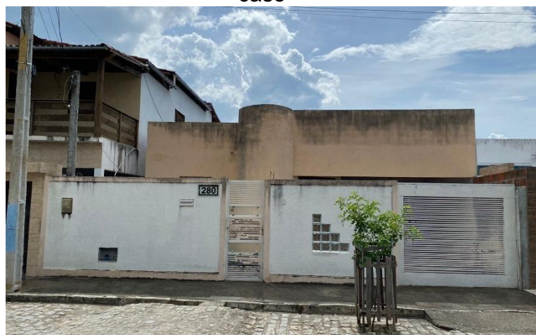
Figura 07 – Edificação habitacional do estudo de caso
