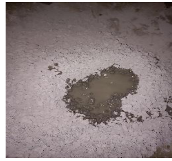
Passo 6: Cimento, Brita 0 e adição de água em pequenas quantidades
