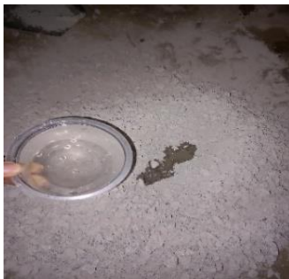
Passo 5: Cimento, Brita 0 inicio da adição de agua a mistura
