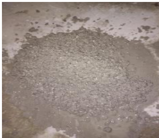
passo 8 : todos os materiais em estado uniforme
