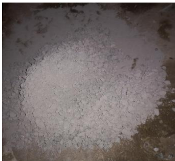
Passo 4: Cimento e Brita 0, mistura uniforme
