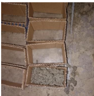
Passo 9: adição do concreto nos moldes retangulares 10x5x5 cm
