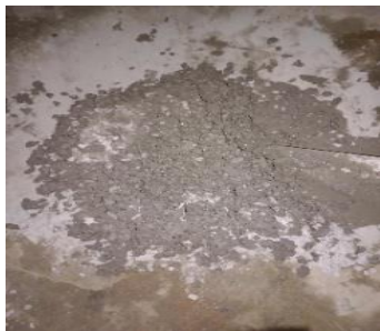
Passo 7: Cimento, Brita 0 e adição total da água
