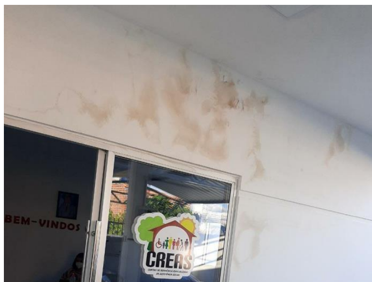
Figura 5 - Infiltração Da Laje Para As Paredes Do CREAS
