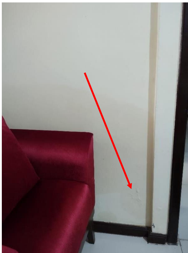
Figura 3 – Presença de umidade e bolhas.
