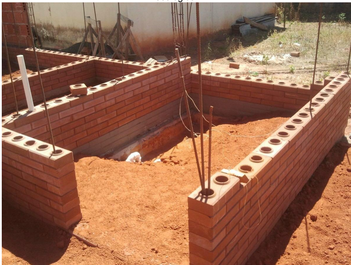
Figura 6 – Processo de execução com uso do tijolo ecológico
