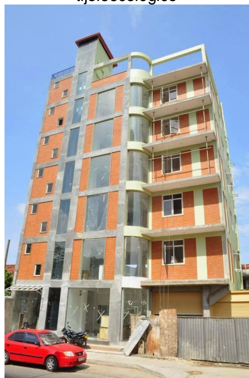
Figura 2 – Prédio executado com tijolo ecológico
